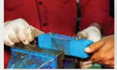
استبدال اجزاء الصمام Replacement of valve parts
